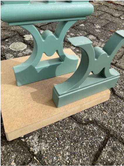
Herr Mattern hat dann das erste Modell gebaut, mittig die Konstruktion des Handlaufs, auch sie nach historischem Vorbild. Die Lehne wurde genauso reduziert behandelt wie der Baluster selbst: quadratischer Querschnitt, keine Verzierung. Den Fuß haben wir noch geändert, weil die vollständig flächige Form nicht mit dem ganzen Baluster übereinstimmte: da wir an anderen Stellen Profile und Absätze gestaltet hatten, musste das hier auch der Fall sein.
